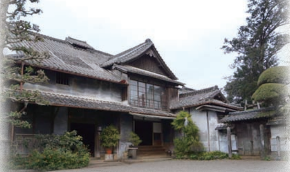
江藤家住宅(外観)
