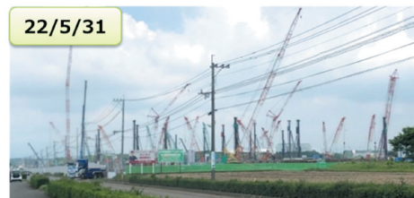
工場建設～着工と完成
