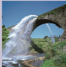
山都町にある通潤橋は山都町の白糸台地の水田に通水する水路橋で1854年に完成した。観光スポットの通潤橋前の棚田で、本実証のデモンストレーションを行う。
